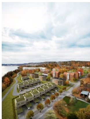
Radhusen, Ormhuset och Kultur- och Gatuhuset i samverkan. Etapp 1, byggnation av Jönköpings nya stadsdel, Strandängen.
